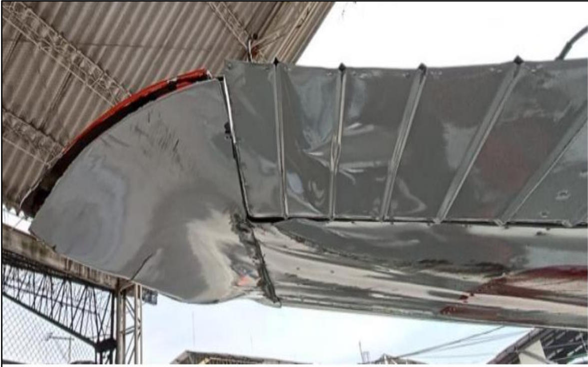
Fotografía 3. Desprendimiento del Wingtip, estación 208.
