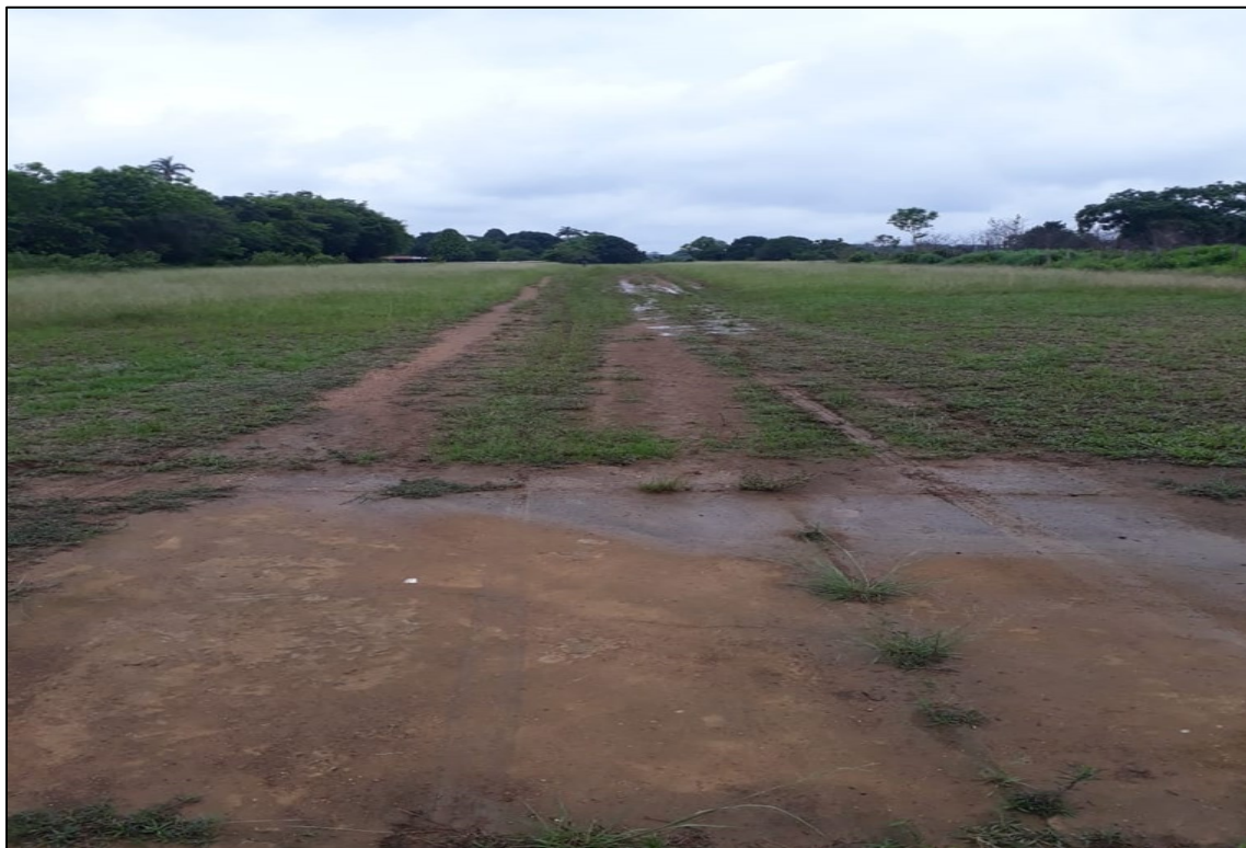
Fotografía No. 2: límite de la capa de concreto en la pista e inicio de la grama que probablemente generó el hidroplaneo.
