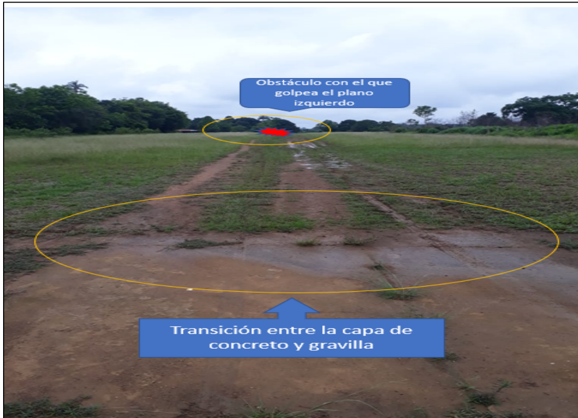
Fotografía No. 7 - Transición entre las dos capas de la pista y zona de hidroplaneo
