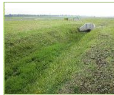
Canal entre alfa 6 y 5
