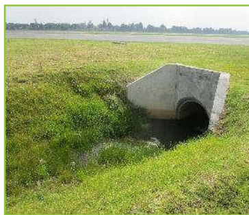
Canal entre alfa 8 y 7
