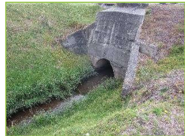
Canal entre bravo 3 y 4
