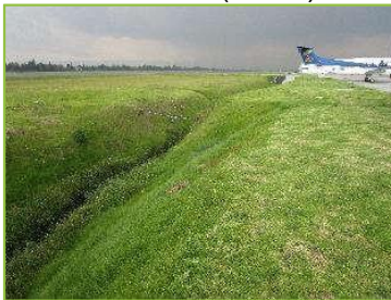
Canal entre bravo 2 y 3
