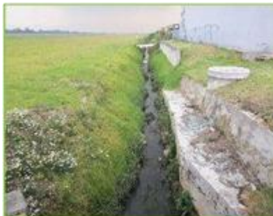
Canal entre bravo 4 y 5
