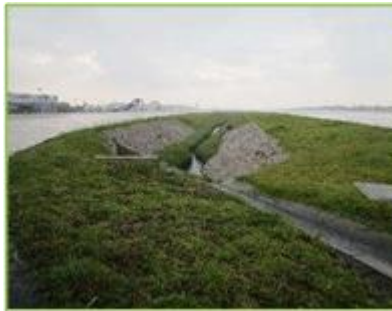
Canal entre bravo 11 y 12
