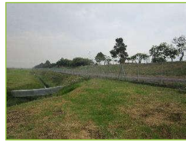
Canal perimetral de la pista norte
