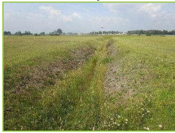
Canal entre hotel 1, con kilo
