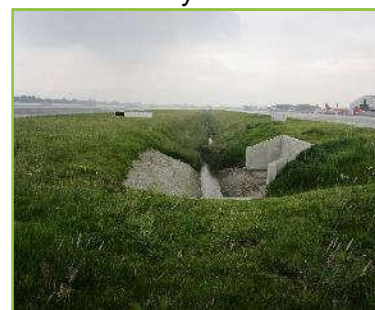
Canal entre bravo 10 y 11
