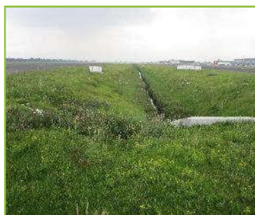
Canal entre bravo 7 y alfa 6 con bravo
