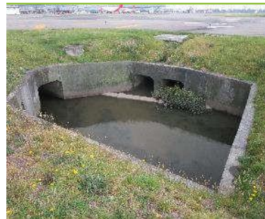
Estructura circular donde llegan varios canales entre M y N
