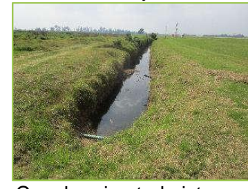
Canal perimetral pista sur
