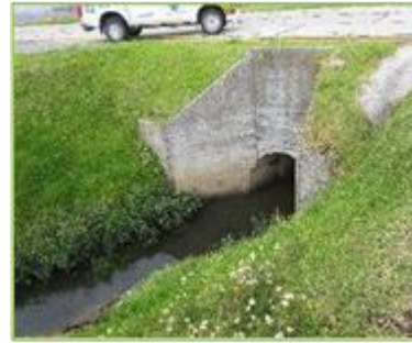
Canal entre alfa 3 y bravo 1
