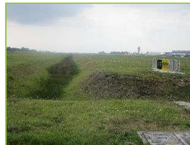
Canal entre kilo 7 y cabecera 31R izquierda
