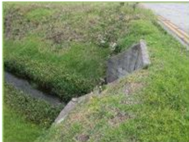
Canal entre bravo 1 y 2
