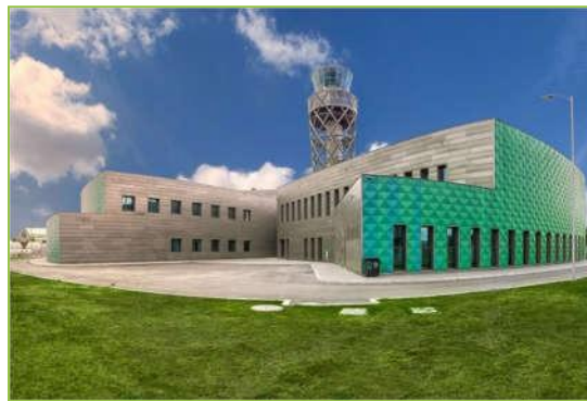
Ilustración 3-9 Vista general del CGAC y Torre de Control
