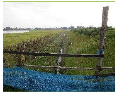
Canal entre bravo 12 y 16
