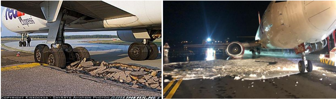
Ilustración 3-46 Daños en pista ocasionados por aeronaves.
