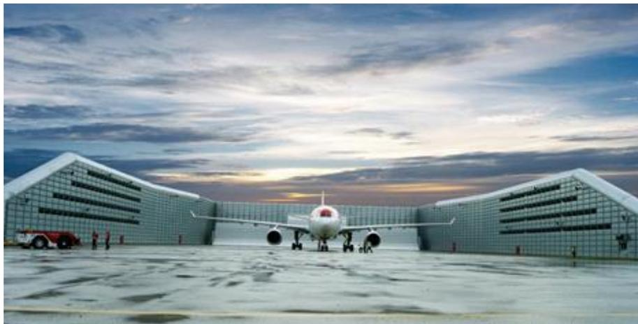
Ilustración 2-38. Recinto de prueba de motores.
