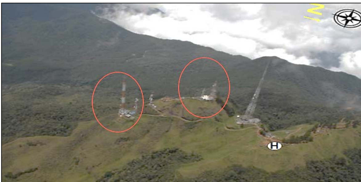
Figura No. 6: Obstáculos circundantes del helipuerto Cerro Santa Ana.
