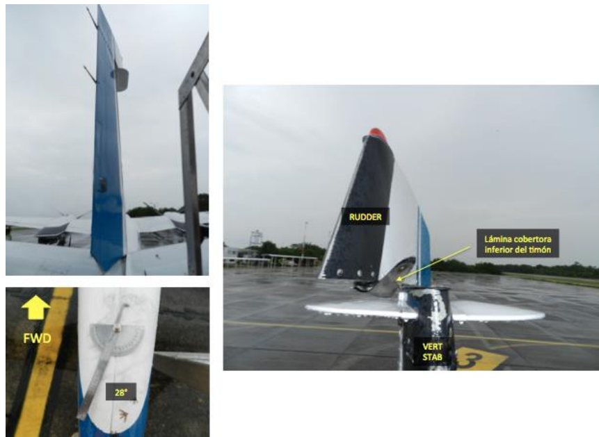
Condición final de atascamiento del timón de dirección aeronave HK1771G
