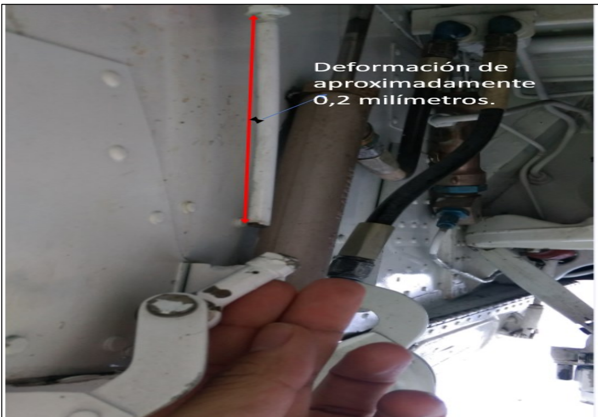
Fotografía No. 7: Deformación del tubo por altos esfuerzos mecánicos
