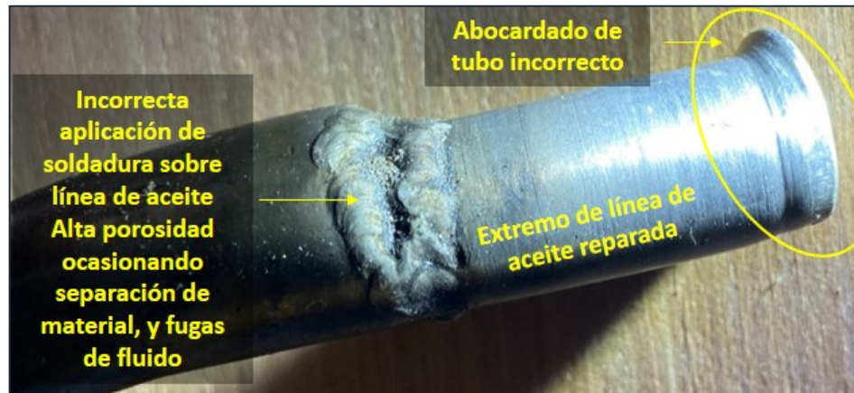
Fotografía No. 7 - Detalles de la línea de aceite del motor No. 1
