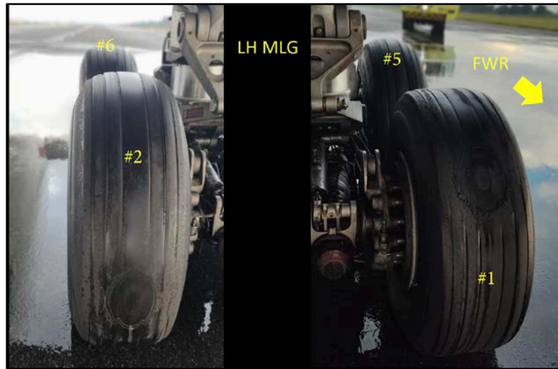
Fotografía No. 5 – Estado final del tren izquierdo YV560T
