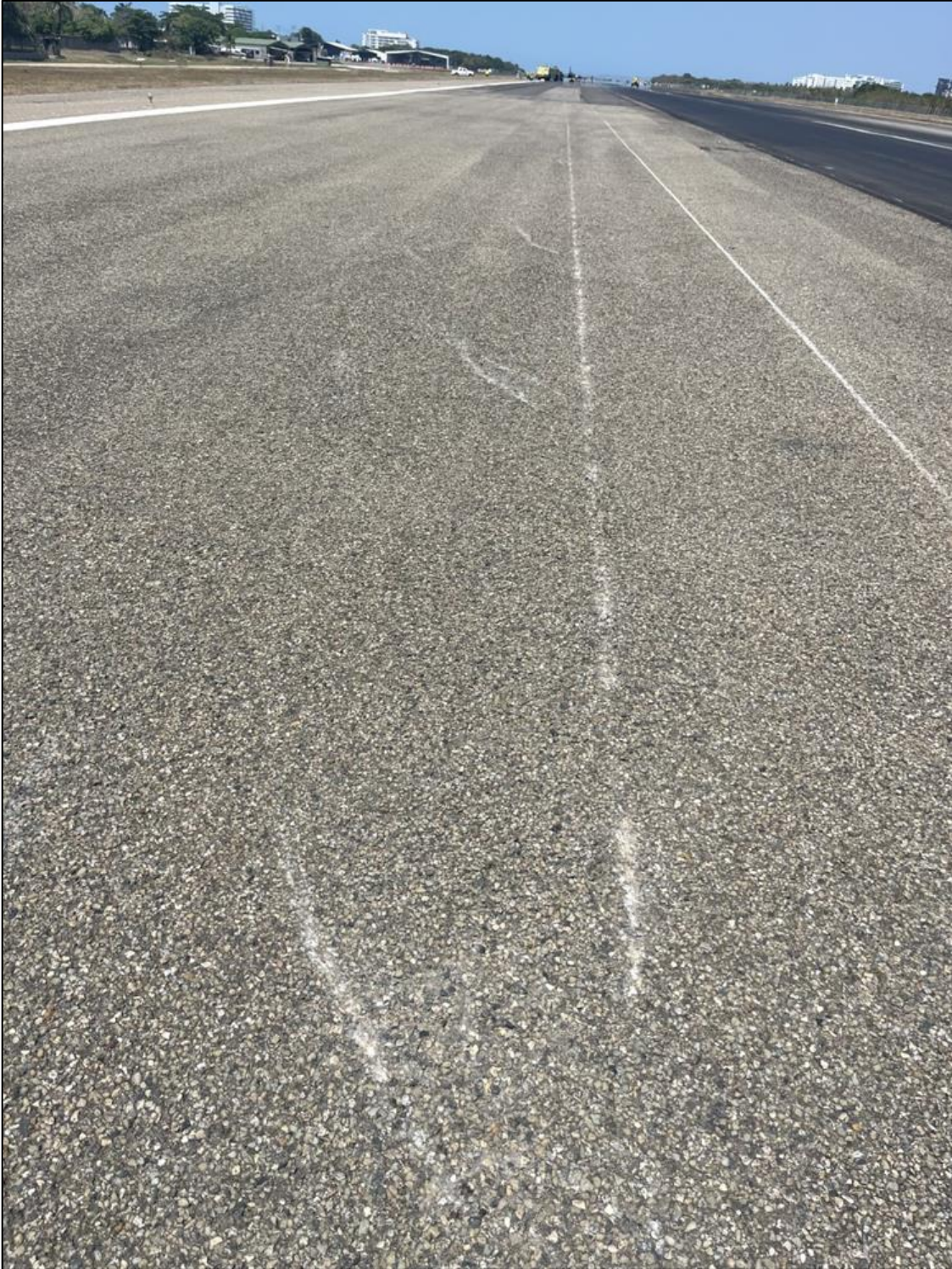
Fotografía No. 2 – Marcas de impactos de la hélice del motor izquierdo contra en la pista.
