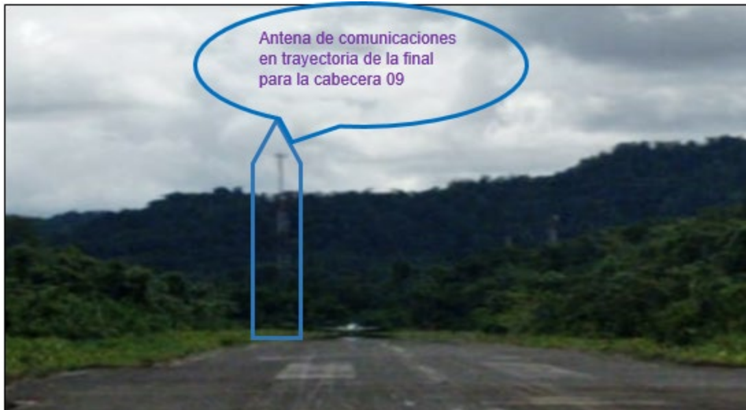
Fotografía No. 3: Torre de antena de comunicaciones en la trayectoria de la cabecera 09.
