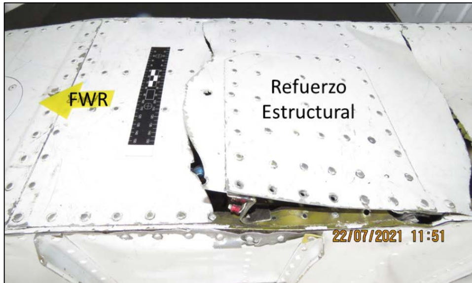
Fotografía No. 3 - Condición de la estructura SABAW de anidamiento tren aeronave HK3065
