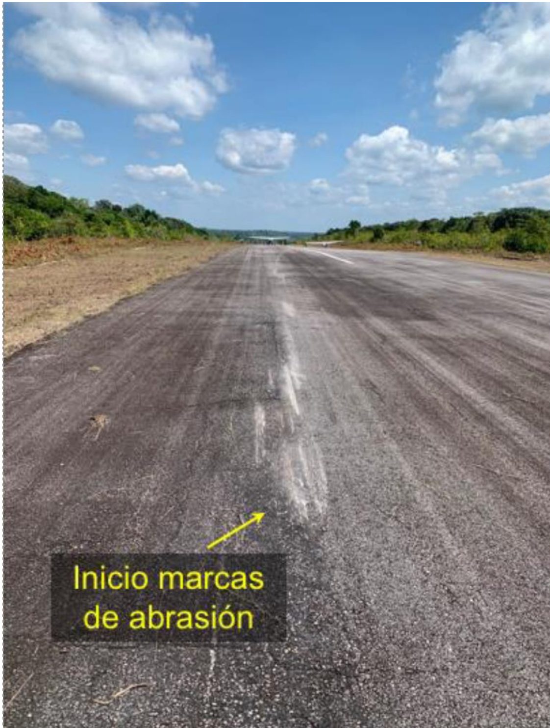
Fotografía No. 3 – Inicio de marcas de abrasión en superficie pista
