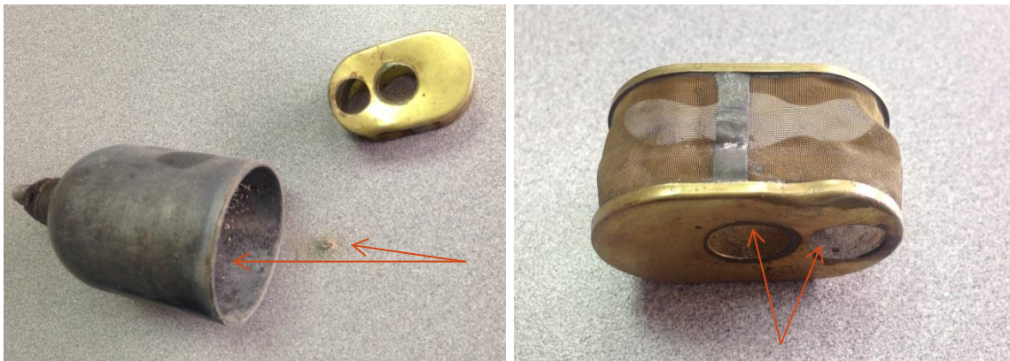
Estado del filtro de combustible donde se observan contaminación en el combustible.
