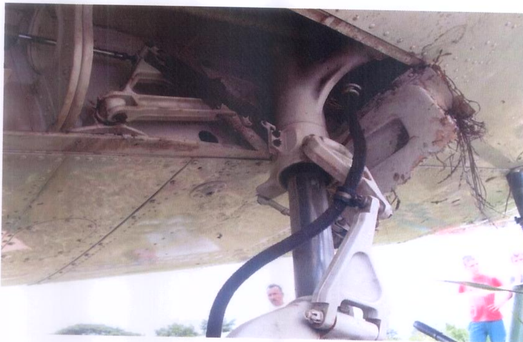
Tren Principal Derecho Extendido y sin evidencias de daños y/o escapes hidráulicos.
