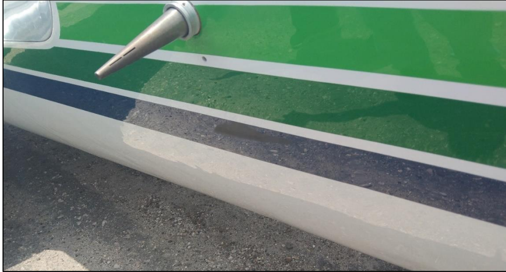
Figura 6. Marcas de transferencia en lado derecho del fuselaje adelante del sensor AOA.
