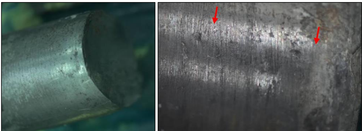
Imágenes No. 17 y 18: Muestra fractura buje. Las flechas indican desprendimiento de material en el interior del buje, especie de erosión y entallas mecánicas.
