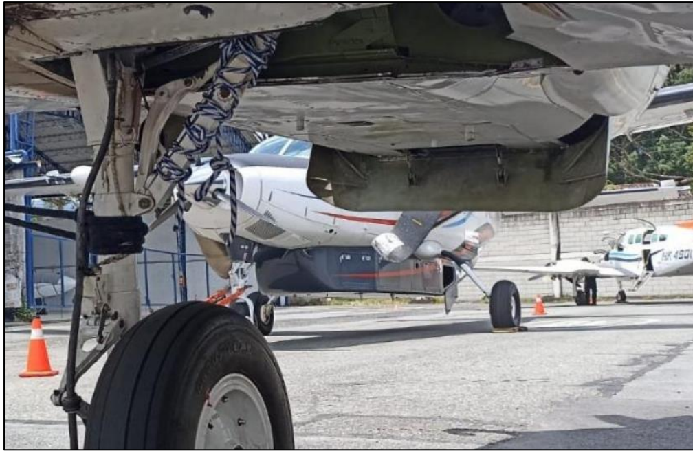
Fotografía No. 4: Estación entre W.S. 46.89 y W.S. 75.24, piel con abolladuras.
