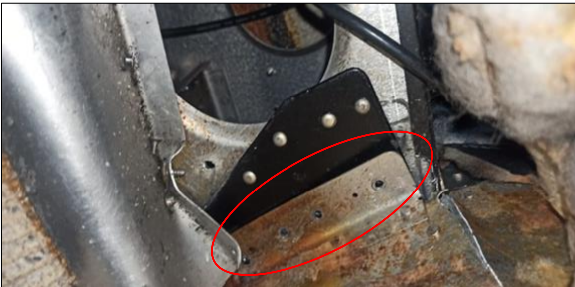
Fotografía No. 8 - Lámina de refuerzo con orificios sin remaches vista desde alojamiento del tren
