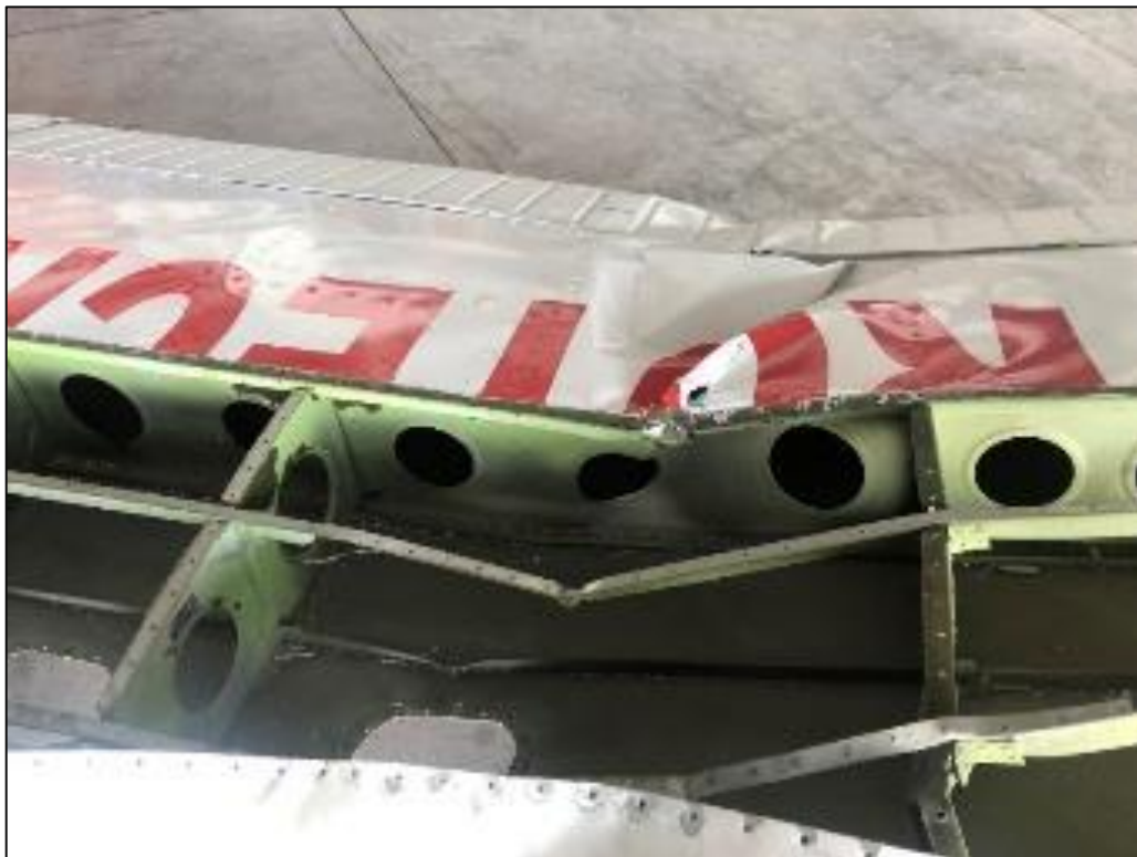
Fotografía 5: Daños en el interior del plano izquierdo.
