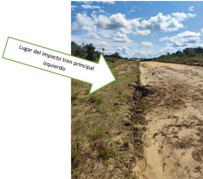
Fotografía No. 3: Montículo de tierra ubicado en el costado izquierdo de borde de la pista 27/09.
