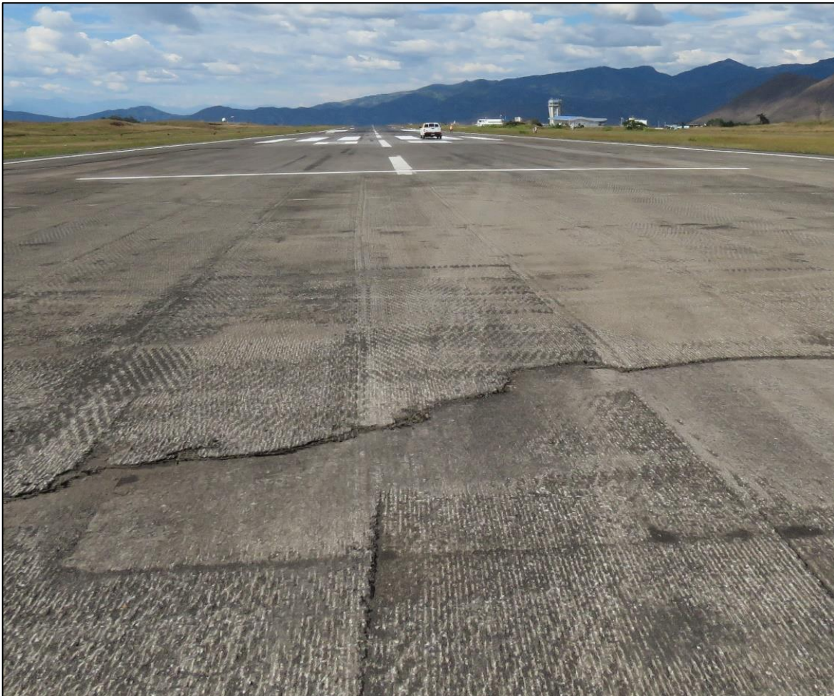
Fotografía No. 4: Superficie cabecera 02 SKPS (umbral desplazado)
