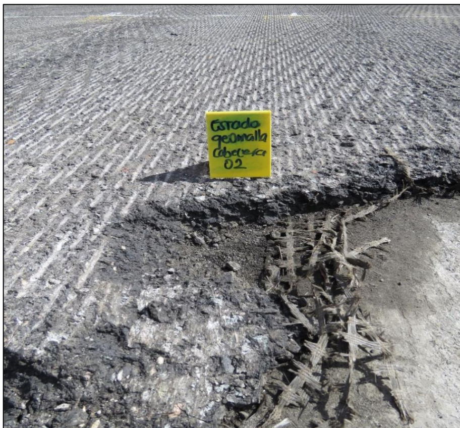
Fotografía No. 6: Superficie cabecera 02 SKPS – Geomalla de refuerzo
