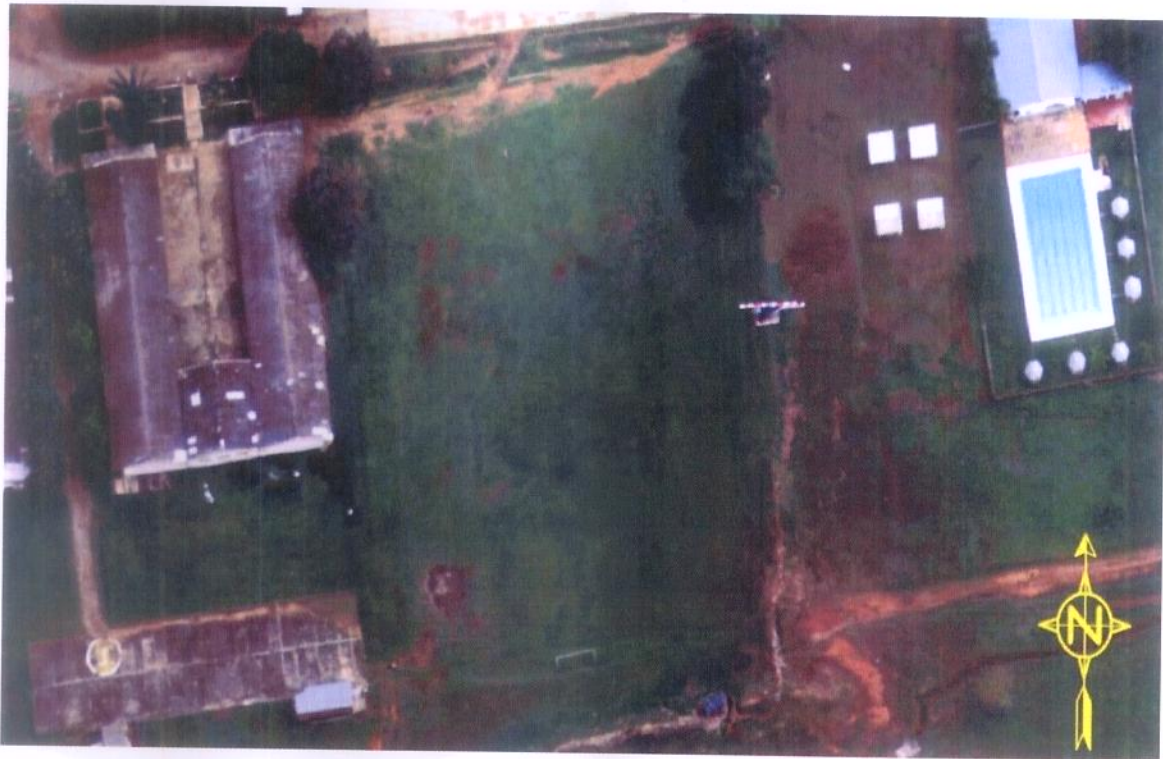
Foto 1.7 Zona de aterrizaje del Batallón de Infantería No. 17 Domingo Caicedo. Al costado occidental, en zona de concreto se encuentran los hidrantes de combustible con su plataforma en cemento.
