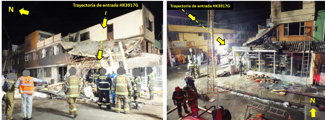
Trayectorias de entrada de la aeronave hacia el terreno
