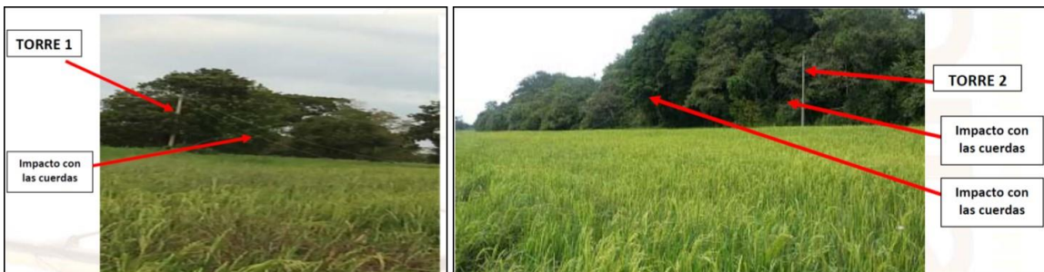
Vista general de los daños en el tendido eléctrico
